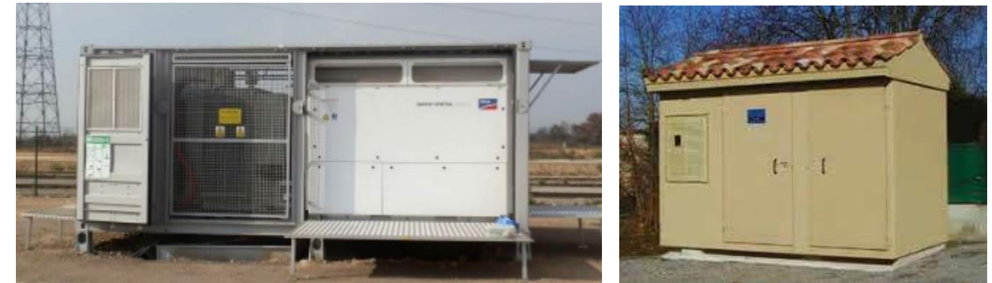
Figure 2 : Illustration des postes de transformation (gauche) et de livraison (droite) qui seront mis en place sur le projet de Bazac (ABO Wind)
